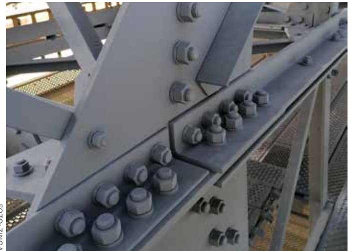
Regalanisering av høyspentmaster for Statnett på på Karmøy i 2021.
